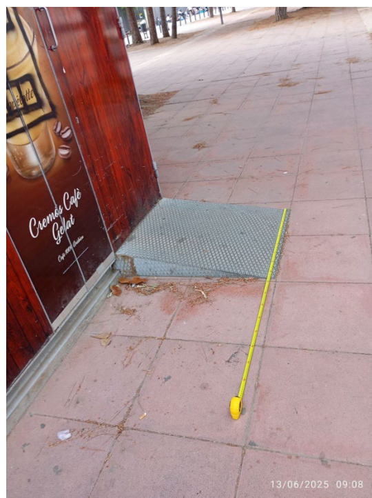
Imatge 4-5-6 Rampa per l'accés al lavabo adaptat no compleix normativa. Es necessari desmuntar aquesta rampa i executar una nova adaptada a les mides del pendent.
