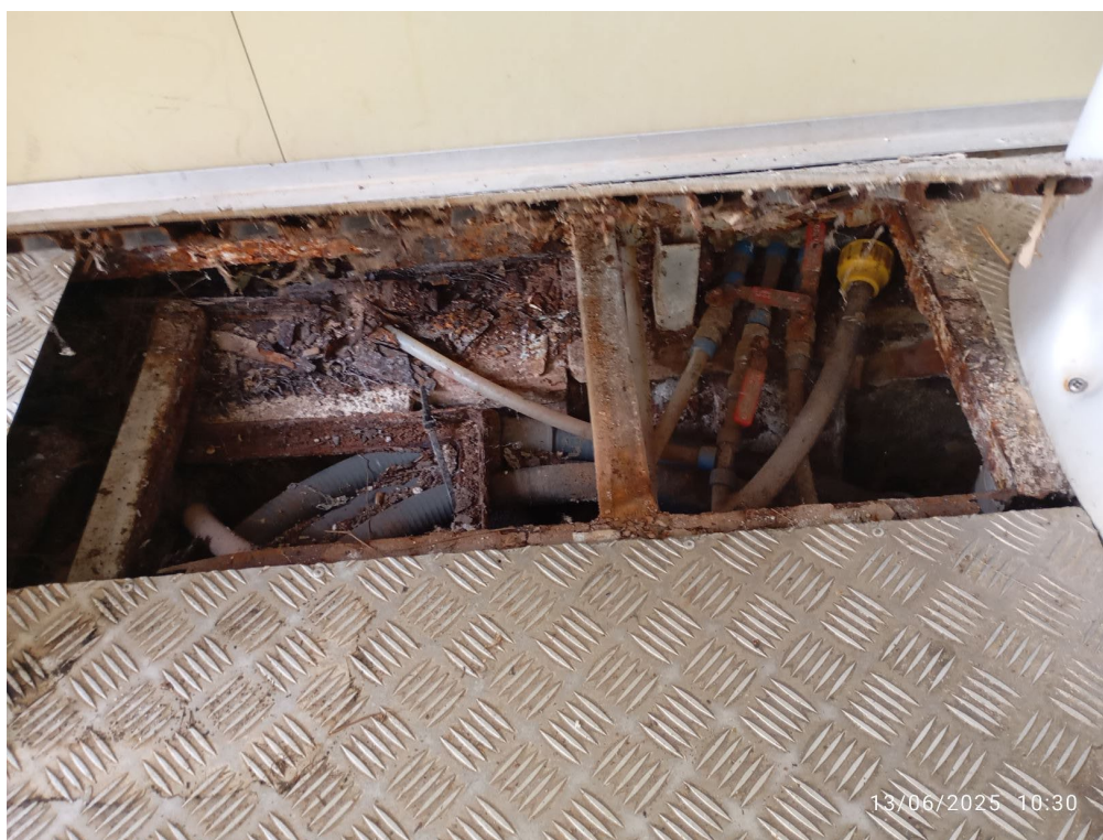
Imatge 7 Rehabilitar l'estructura de suport del paviment de xapa que està malmesa en les zones humides dels banys
