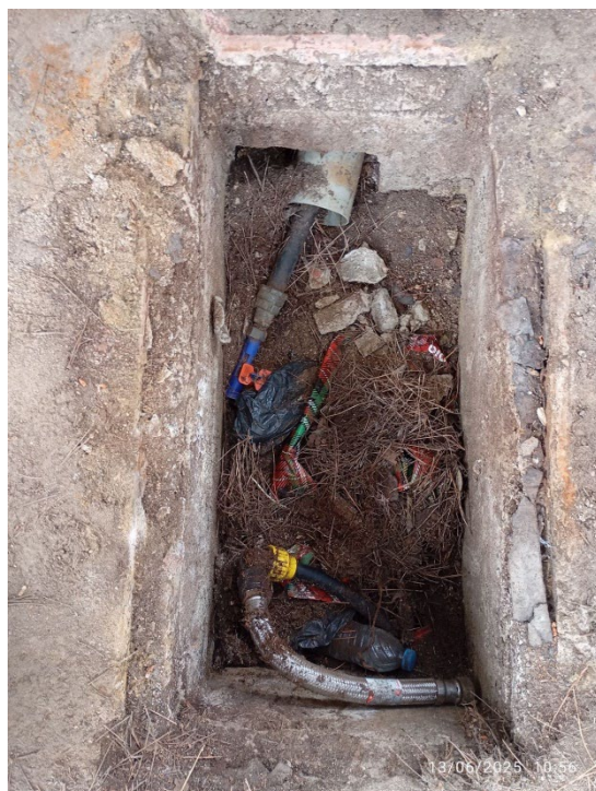
Imatge 2-3 Rehabilitar l'arqueta del comptador d'aigua i posar nova tapa.
