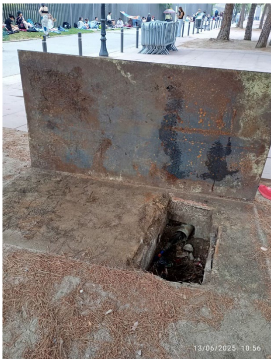
Imatge 2-3 Rehabilitar l'arqueta del comptador d'aigua i posar nova tapa.
