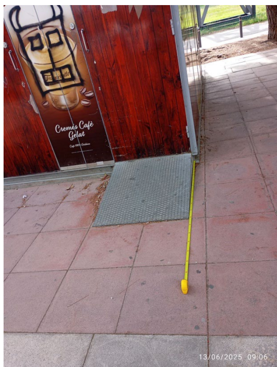
Imatge 4-5-6 Rampa per l'accés al lavabo adaptat no compleix normativa. Es necessari desmuntar aquesta rampa i executar una nova adaptada a les mides del pendent.
