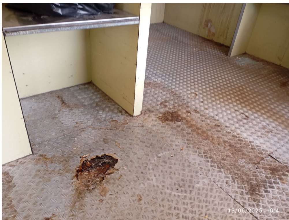
Imatge 8 Substituir el paviment malmès amb xapa tipus damero galvanitzada similar a l'existent.
